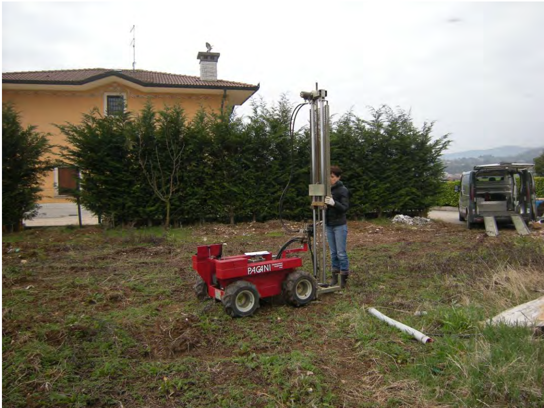
Foto 1: Esecuzione della prova penetrometrica n°1
